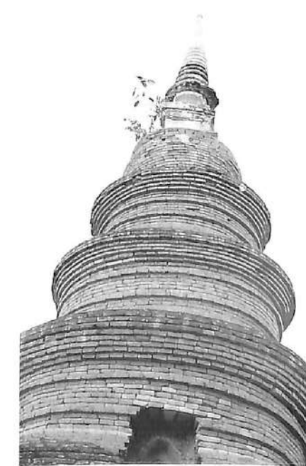
รูปทรงขององค์เจดีย์ เกิดขึ้นจากการเรียงแผ่นอิฐจากฐานสู่ยอด
